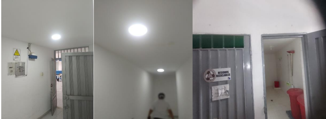
Fotografía N° 6 Pasillo de acceso al cuarto de patógenos Sede Granjas
